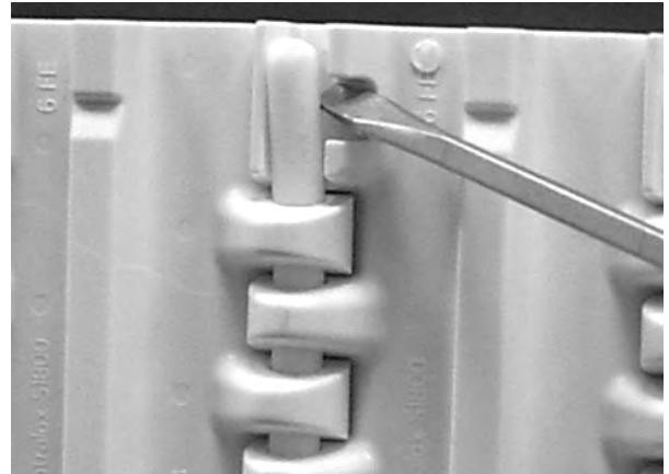
Figure 206: Heben des Scharnierstabes über das Verschlussystem
